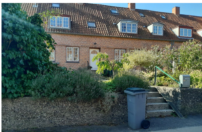
Fra Hvidkildevej 39 til Hvidkildevej 67 er der en niveauforskel på op til ca. 1 m mellem gaden og forhaverne, som formidles med støttemur og trapper.
